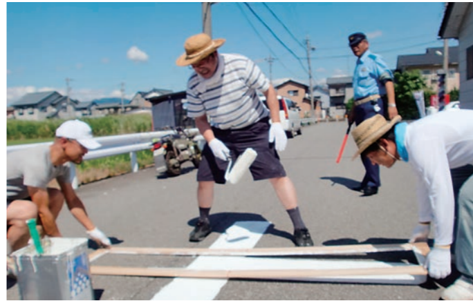
危険交差点におけるクロスマーク標示作業
